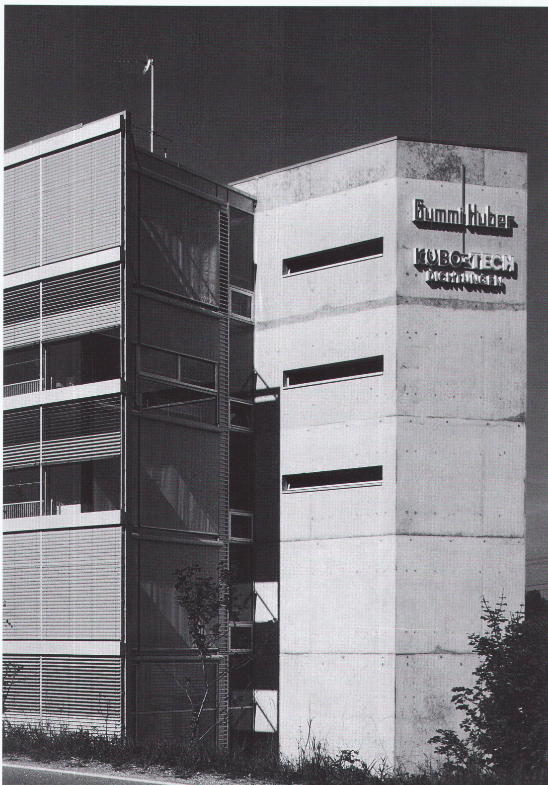
Südfassade Foto: M. Schaufelberger, Zürich
