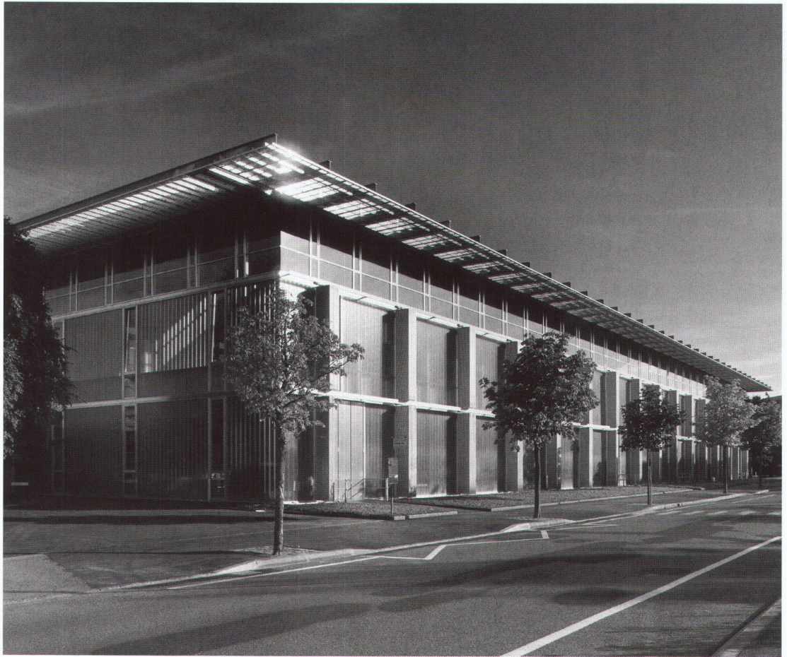
Strassenfront mit Streckmetall- Paneelen ▷ Front côté rue avec panneaux en métal déployé ▷ Road frontage with expanded metal panelling
