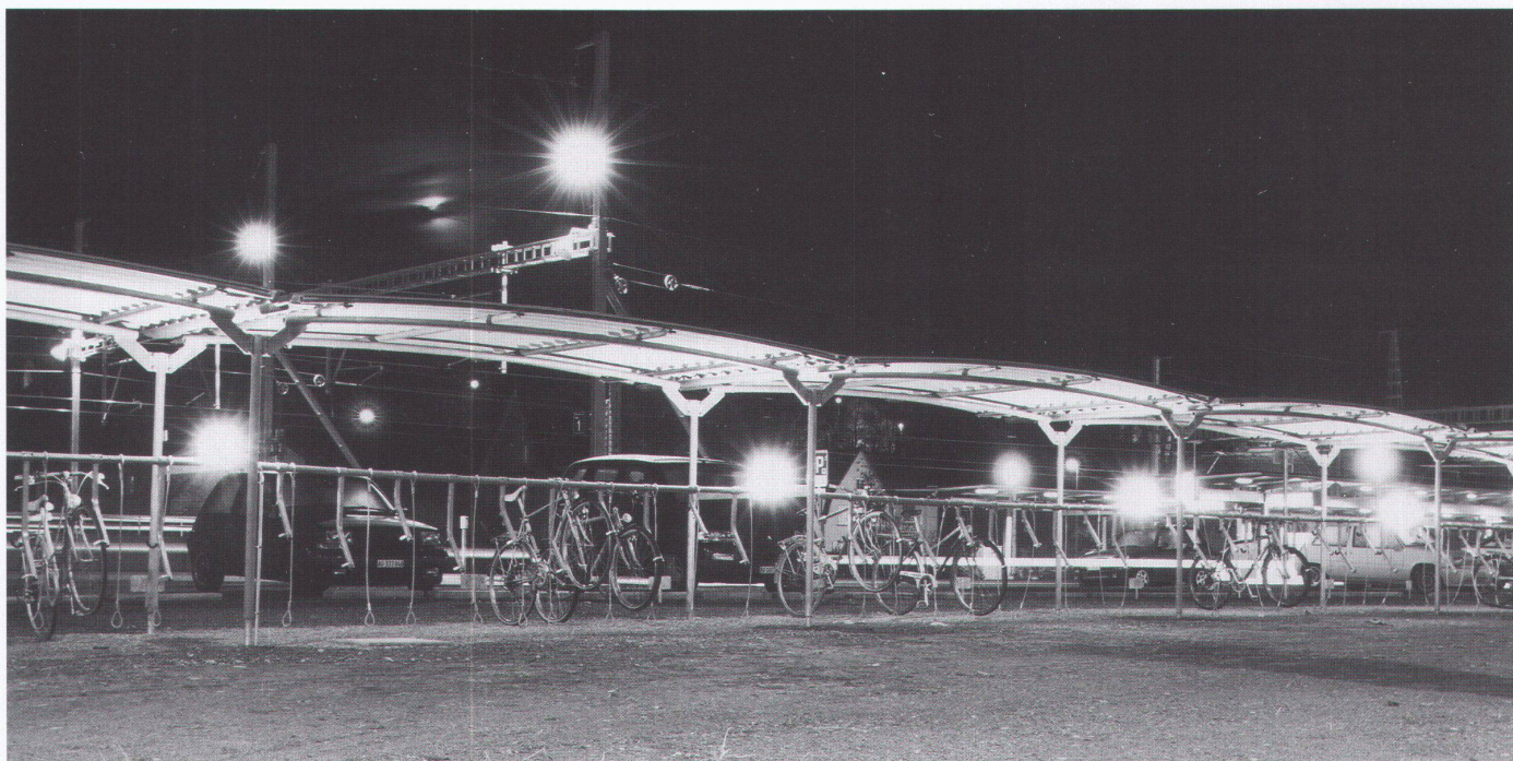
Fahrradüberdachung einseitig, Bahnhof Turgi, Dach als Lichtreflektor
