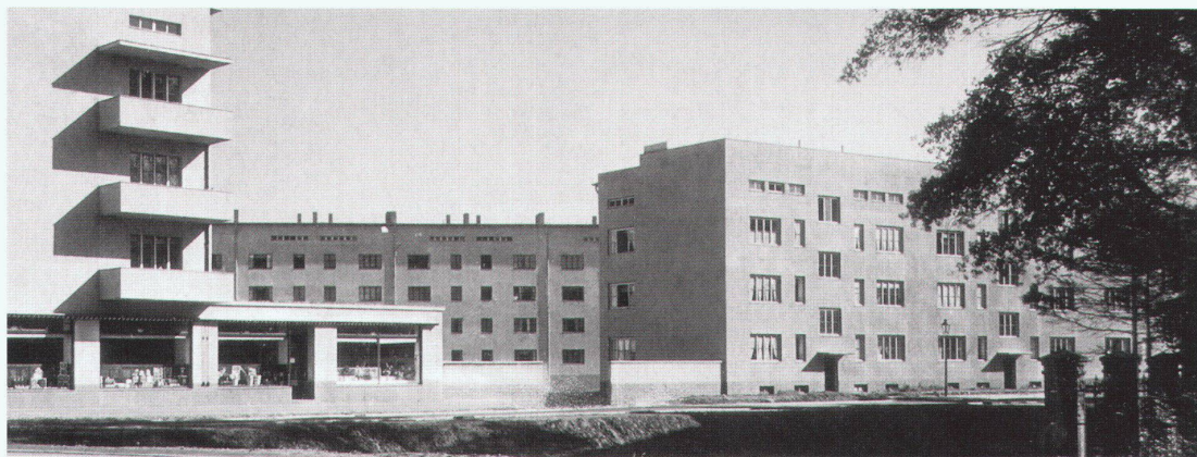
Siedlung an der Rothenseer Strasse in Magdeburg, Architekt Carl Krayl, 1929
