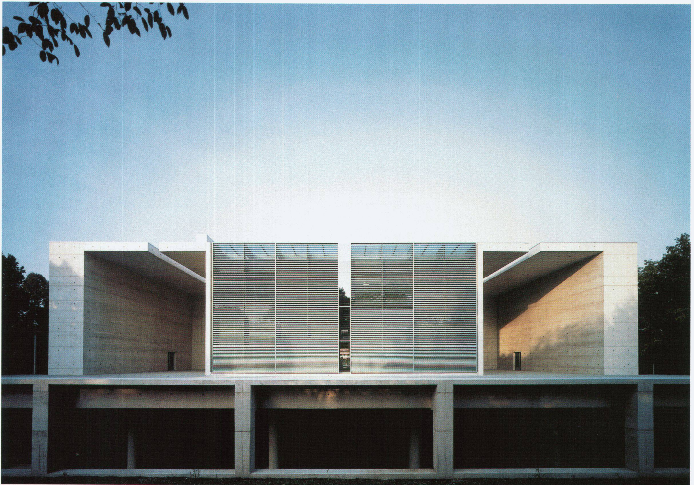
Rückfassade mit Anlieferung
