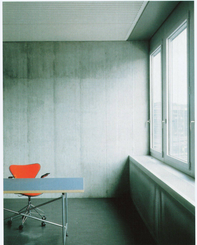
Büro mit Weisszement- Deckenelementen
