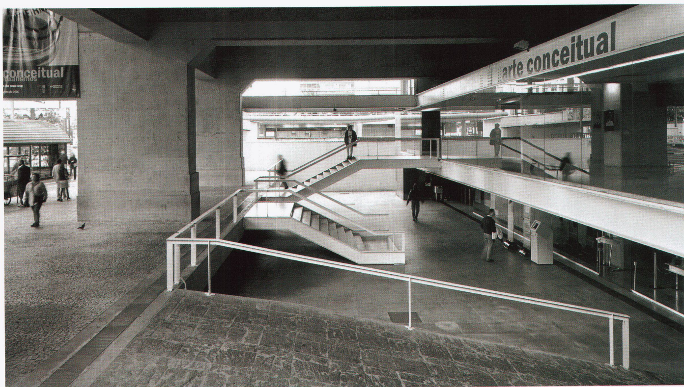
Paulo Mendes da Rocha: Kulturzentrum FIESP, São Paulo, 1996. Zugang von der Avenida Paulista – Bild: Nelson Kon
