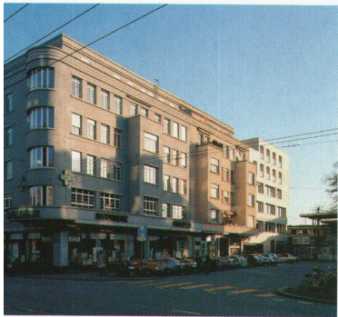
Ansicht vom Bahnhofplatz aus
