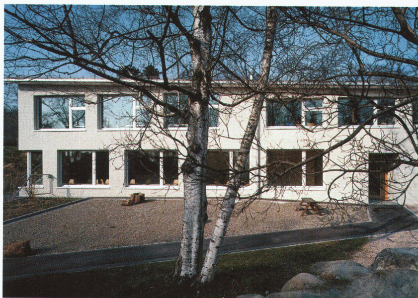
Erweiterung: vom Pausenplatz, von der Talseite
