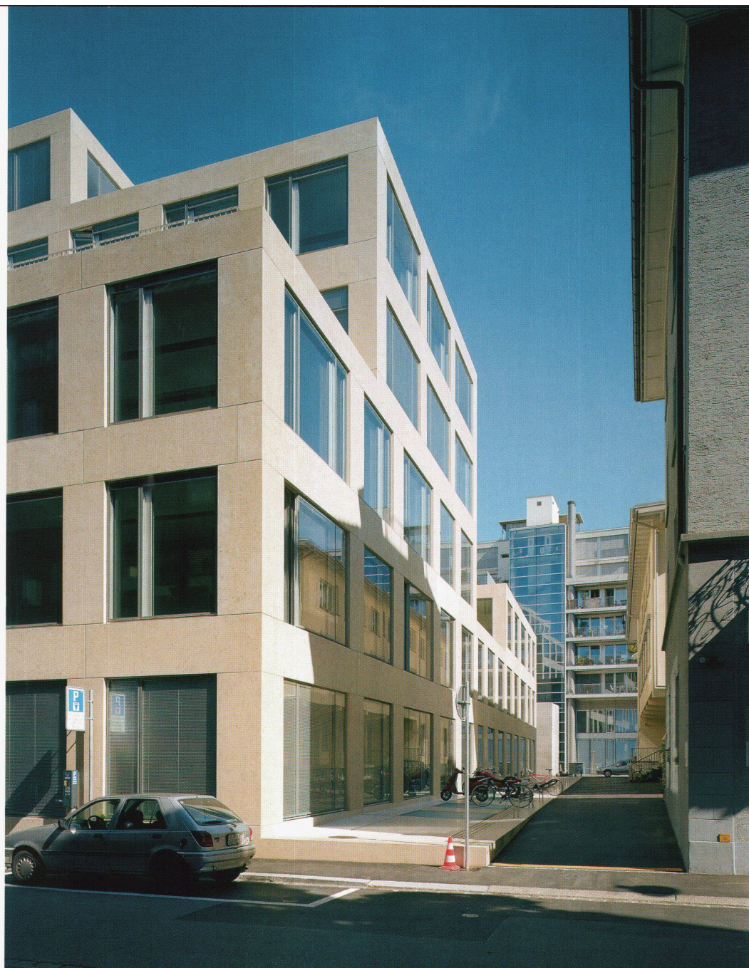
Rückwärtige Fassade mit Blick nach Osten
