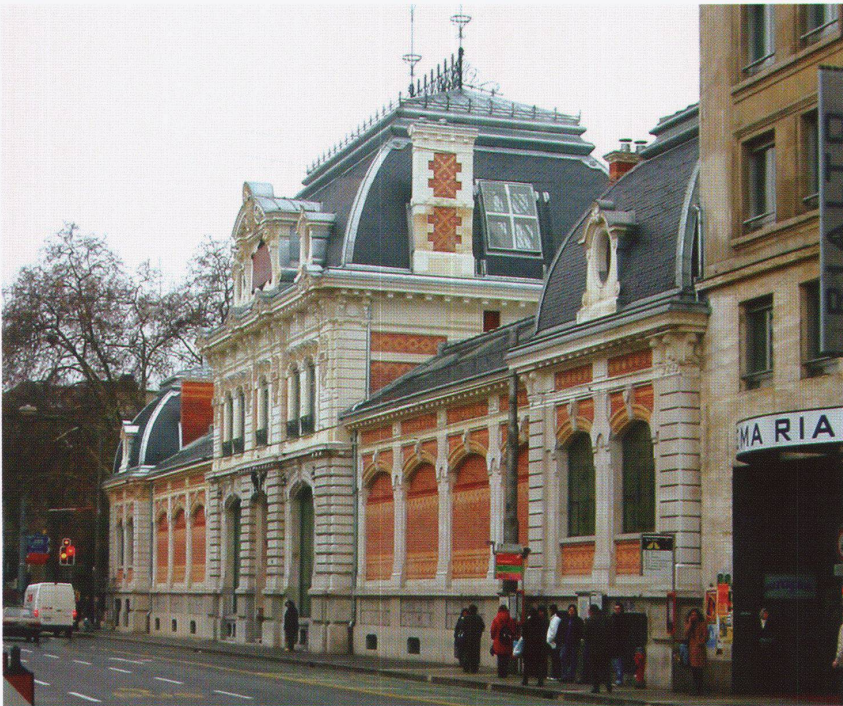
Hauptfassade nach der Restaurierung, Dezember 2002. – Bild: Graf &amp; Menoud
