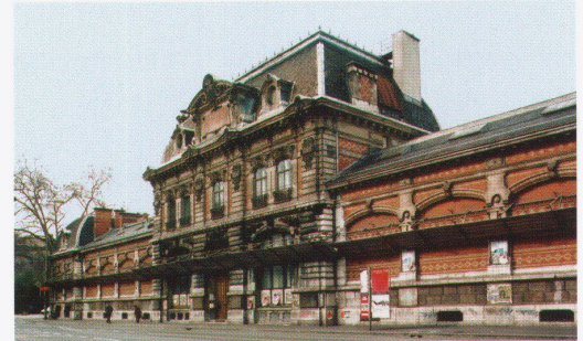
Hauptfassade vor der Restaurierung, März 2001. – Bild: Graf &amp; Menoud
