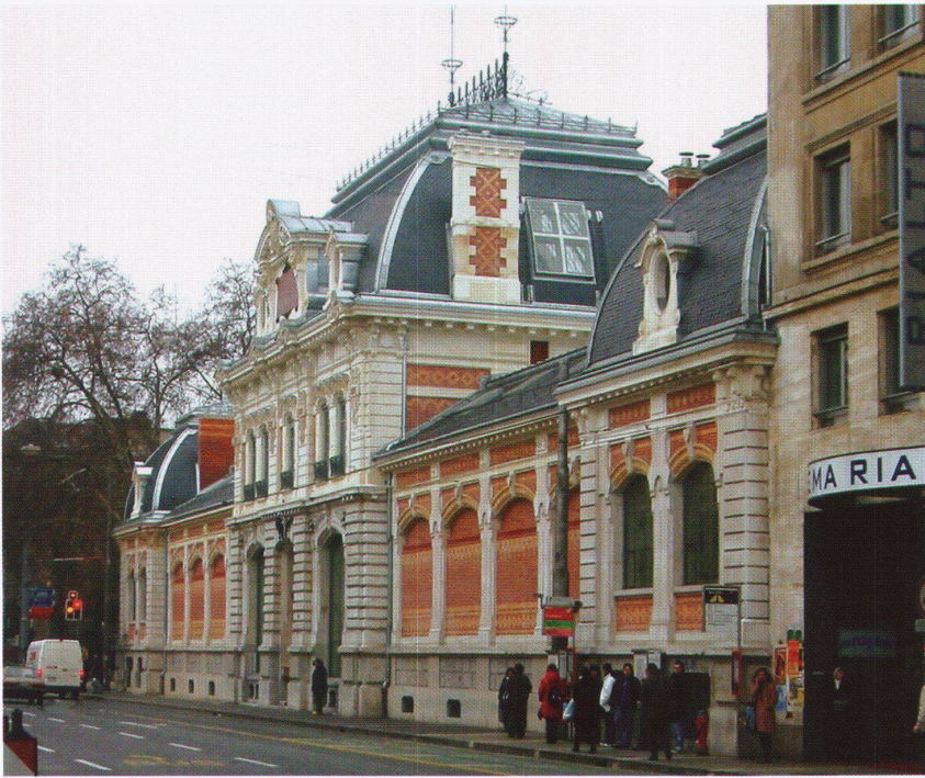
Hauptfassade nach der Restaurierung, Dezember 2002. – Bild: Graf &amp; Menoud
