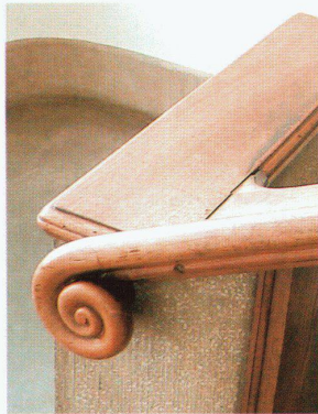
Oben: Korridor, Zustand vor der Sanierung Unten: Haupttreppe, Detail
