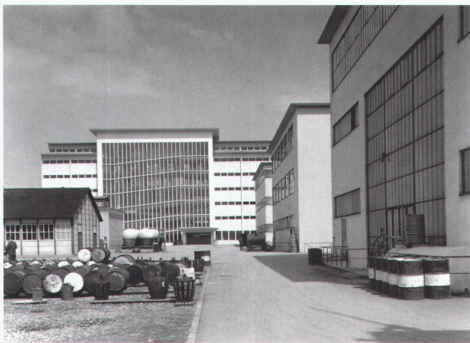
Roland Rohn, Lagerhaus Bau 41, Roche Basel, 1947–1971. Westfassade mit Rampenhaus, rechts im Bild Fabrikbauten von Salvisberg (im Vordergrund) und Rohn
