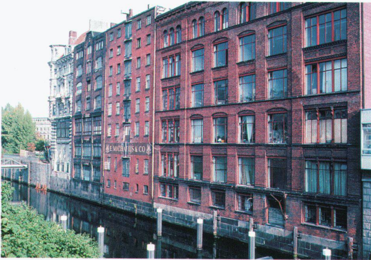
Die Speicherfronten der «Fleetinsel»-Häuser, um 1985, vor der Neubebauung der Umgebung. – Bild: Hermann Hipp
