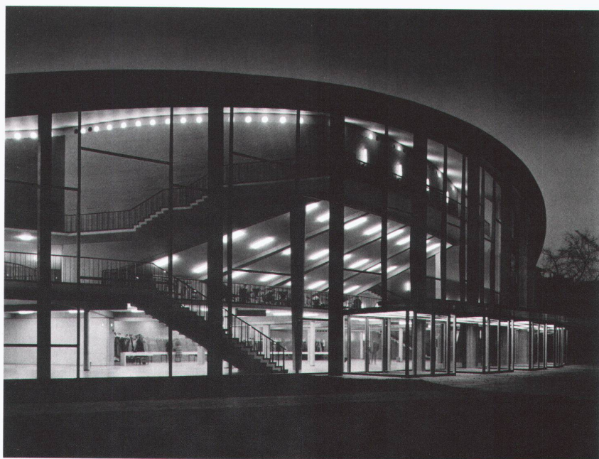
Auditorium Maximum der Universität Hamburg, 1957-59 Grosses Bild rechts: Grossmarkthallen. – Bilder: E. Scheel
