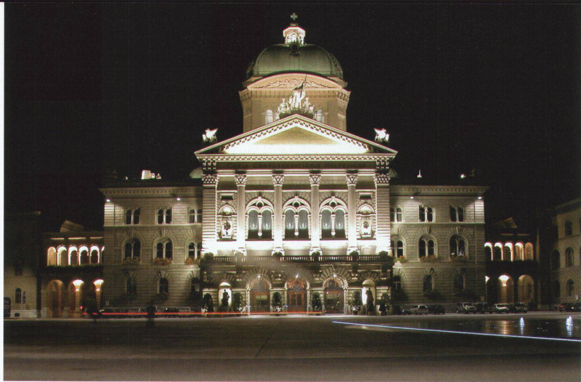
Neue Anleuchtung des Parlamentsgebäudes mit markanter Präsenz des Mittelrisalits. – Bild: Nott Caviezel
