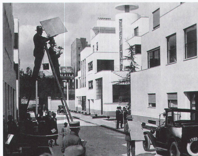
Dreharbeiten zum Film «La Sirène des Tropiques», 1927, in der Rue Mallet-Stevens, Paris
