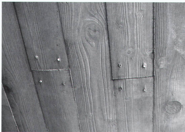
SVB hinterlässt ein gestochen scharfes Abbild der Schalungsstruktur, wie hier beim Science Center «Phaeno». – Bild aus: Beton- und Stahlbetonbau, Heft 1, 2004.
