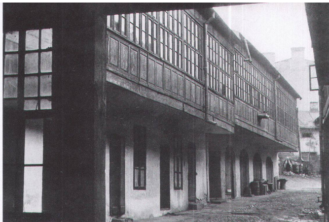
4 Haus in Bukarest, gebaut Anfang des 17. Jahrhunderts, umgebaut um 1855
