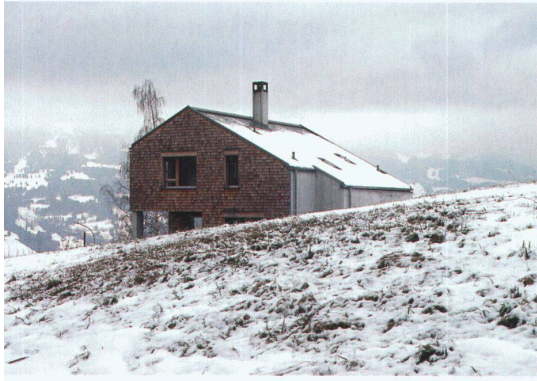
Architekten: Peter Märkli und Gody Kühnis Mitarbeit: Urban Blaas Bauingenieur: Hoch und Gassner AG, 9495 Triesenberg Baumeister: Marzell Schädler AG, 9497 Triesenberg Planung und Ausführung: 2001–2002 Fotos: Andrea Helbling/Arazebra
