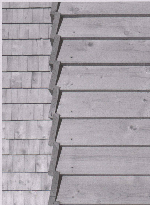
Schalung aus Bohlenbrettern
