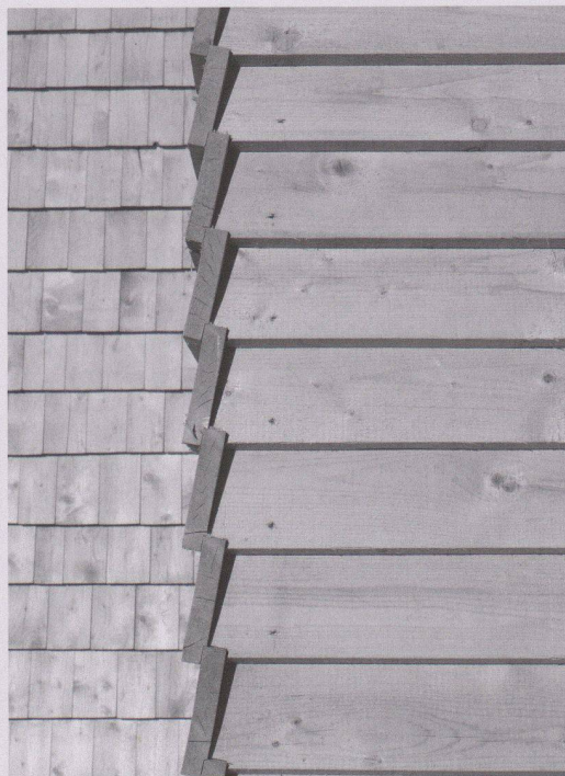
Schalung aus Bohlenbrettern
