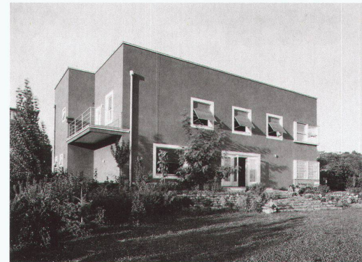
Villa Neumark, Brno, Vinařská-Str. 38, 1928–1929. Villa für den Textilfabrikanten und britischen Honorarkonsul Walter Neumark. Dies ist die zweite von Wiesners drei Brüner Luxusvillen, mit für ihre Zeit ungewöhnlich farbigen Fassaden, Grundrissen in L-Form mit einem Hauptwohnflügel und einem lotrecht dazu angeordneten Serviceflügel, mit einer Eingangshalle, einer geraden Einzellauftreppe längs der Eingangsfassade und mit einer Sala Terrena an der Ostseite des Bauwerks. Das für seine Zeit ungewöhnlich farbige und norditalienisch inspirierte Äussere kombiniert Wiesner in einer «dynamischen Symmetrie» gekonnt mit englischen Schiebefenstern.
