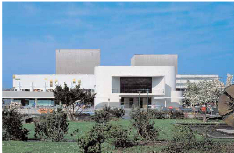
Ostansicht mit neuem Portalgebäude. Unten: vor dem Umbau
