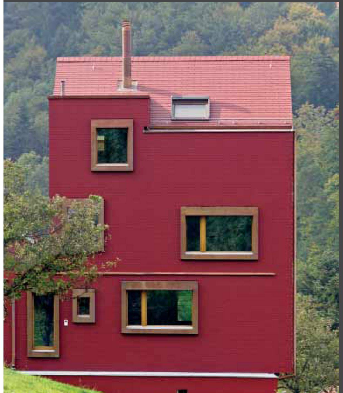
Architekt: Hubert Bischoff , Wolfhalden Dach: DACHSCHIEFER Fassade: FASSADENSCHIEFER
