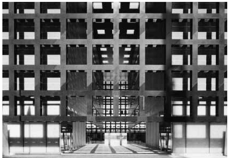
Geschäftshaus «Ferriera» in Locarno, 2003
