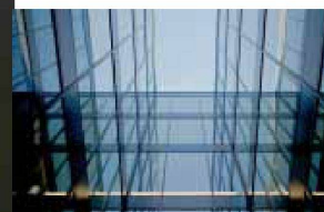
Hartmann setzt visionäre Architektur um: Fassadenbau
