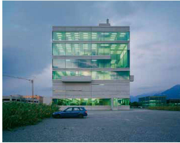
marte.marte, Bürohochhaus SIE, Lustenau (Vorarlberg) 2004
