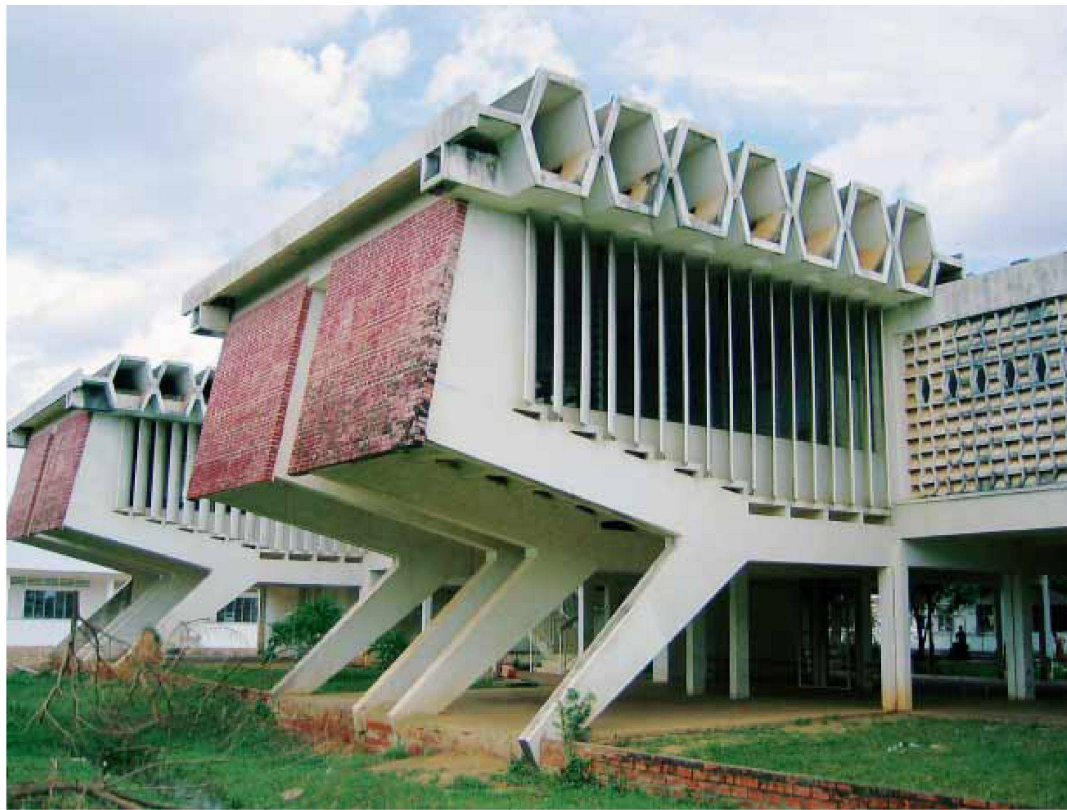
Spezialhörsäle, vom Boden abgehoben. – Bilder: K. Stehrenberger und A. Flury 2005
