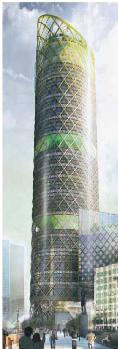
«Tour phare La Défense», Paris, von Jacques Ferrier mit aussen liegender Tragstruktur. Bild: Jacques Ferrier
