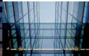
Hartmann setzt visionäre Architektur um: Fassadenbau
