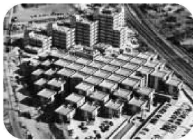
Herman Hertzberger, Bürogebäude Apeldoorn
