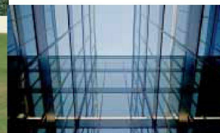
Hartmann setzt visionäre Architektur um: Fassadenbau Hartmann ist immer für Sie da: auch bei Service und Reparaturen
