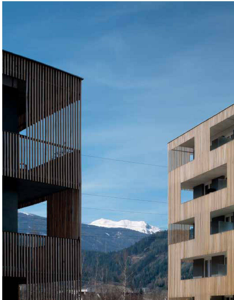
Wohnsiedlung Mitterweg, Innsbruck (1997)
