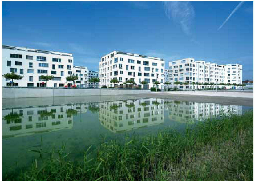
Wohnüberbauung Glattpark in Opfikon, 2006–2009.– Bild: Guido Baselgia
