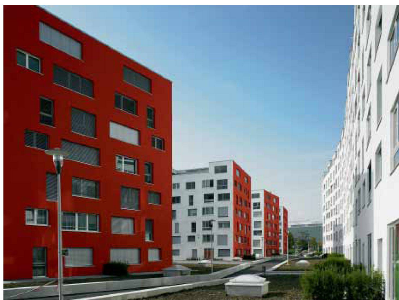
Glattpark, Farbgebung der Fassaden von Mayo Bucher. – Bilder: Guido Baselgia
