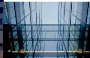
Hartmann setzt visionäre Architektur um: Fassadenbau
