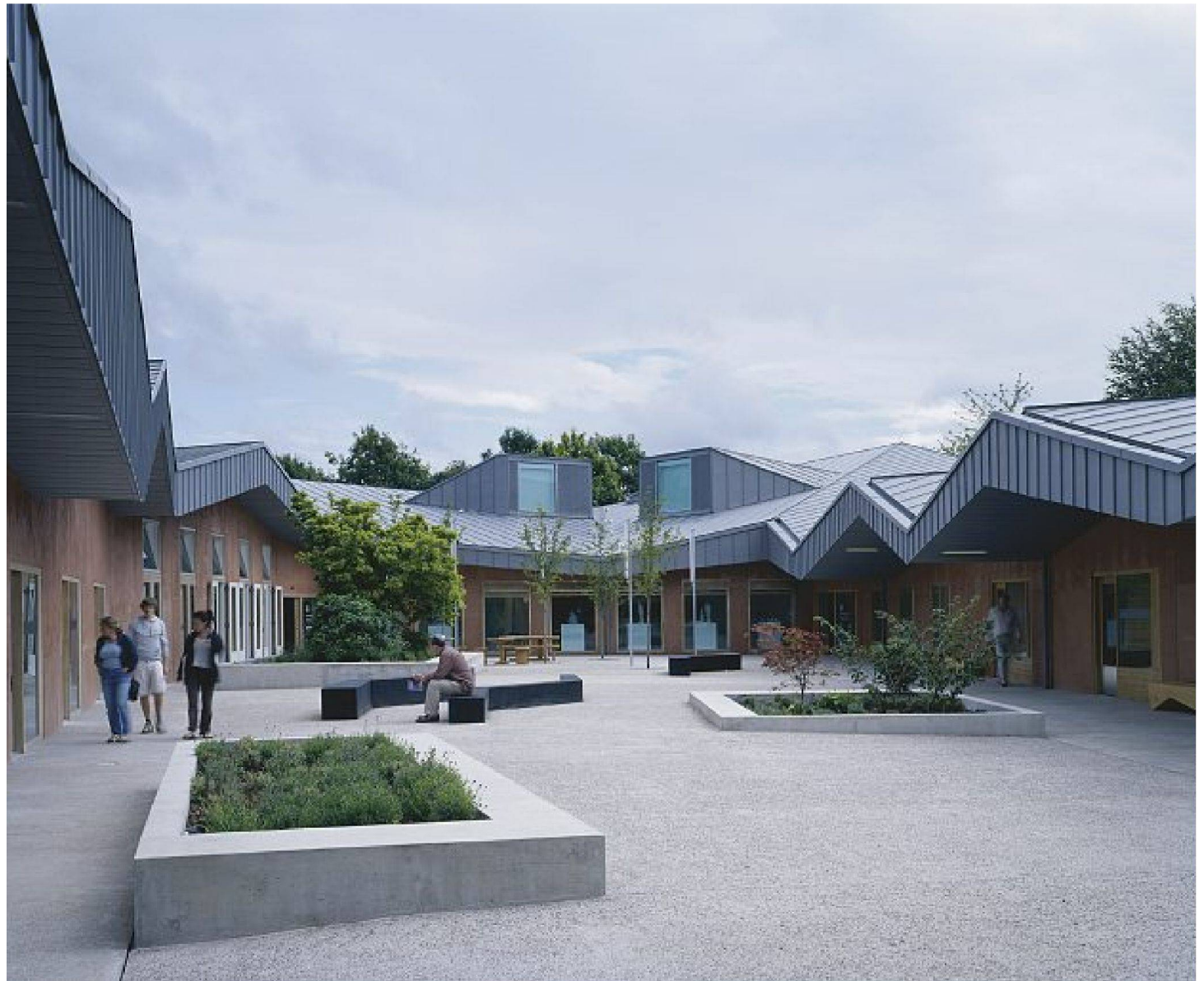
Innenhof und bewegte Dachlandschaft des Centre for Applied Arts in Ruthin. – Bild: Ioana Marinescu
