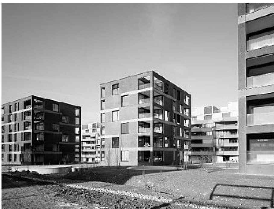
Punkthäuser, im Hintergrund das Langhaus
