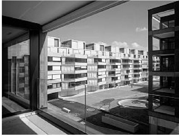
Blick aus einem Punkthaus in den Garten
