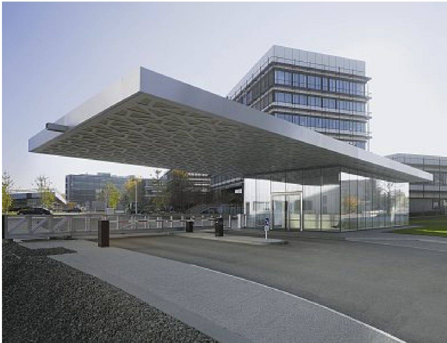
oben: Zwanzig-Meter-Auskragung des Stahldachs über dem Pfortnerhaus unten: Das lasergeschnittene Ornament an der Unterseite zeigt den Kräfteverlauf im Dach. – Bilder: Zoëy Braun
