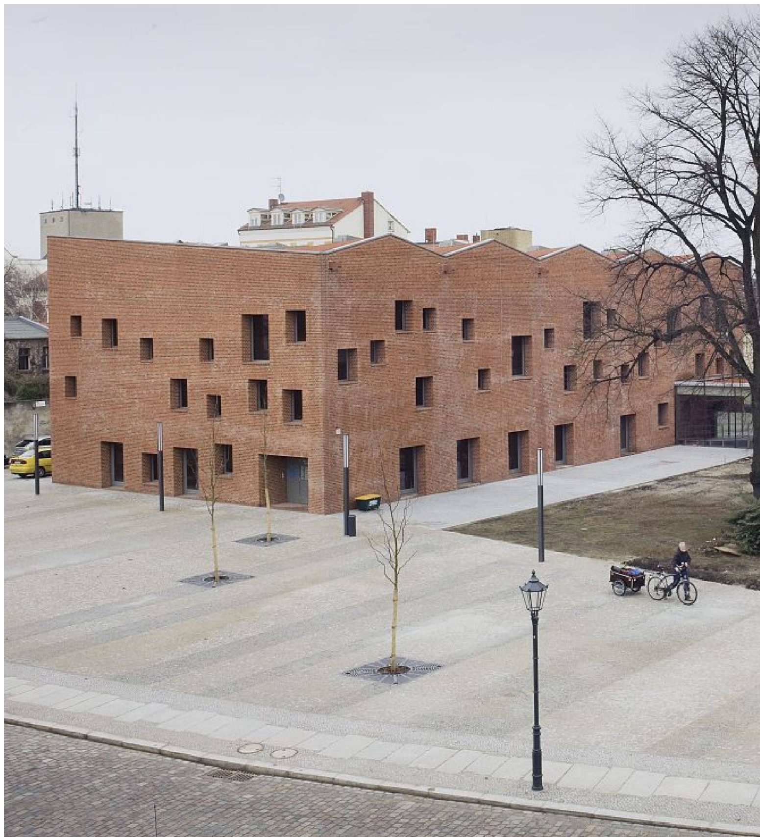
Dreigeschossig, voluminös, gewichtig: Neubaukörper der Bibliothek
