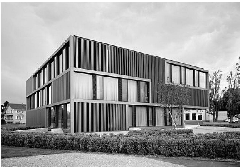
bâtiment scolaire revêtu de lamelles métalliques
