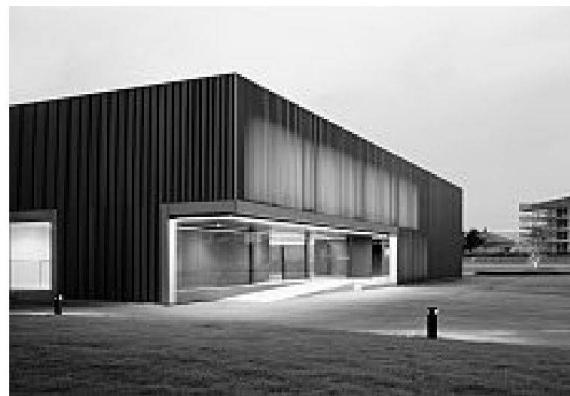
salle de gymnastique avec la même plasticité de la façade
