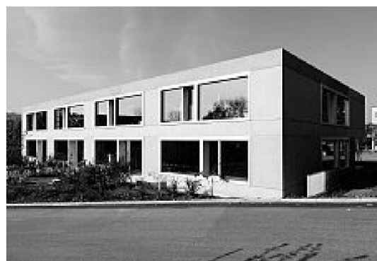
Blick von Nordosten auf den zweigeschossigen Baukörper
