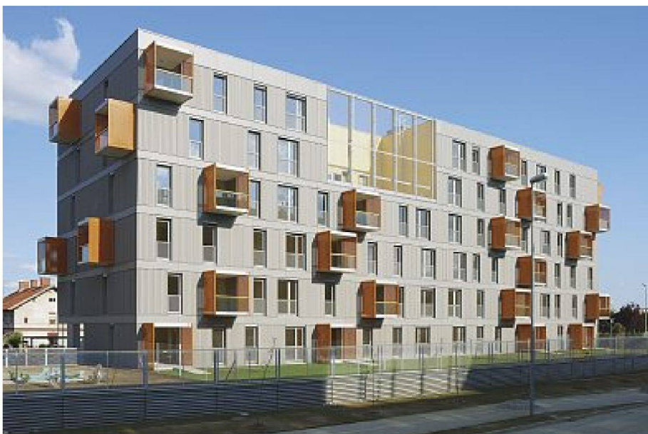
mb Wohnungsbau (2002–2007): Die gemeinsamen Aussenräume liegen im Raumkörper.
