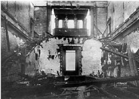
Links: Berlin, November 1943: die ausgebrannte Treppenhalle kurz nach dem Bombenangriff. – Bild: © SMB/Zentralarchiv
