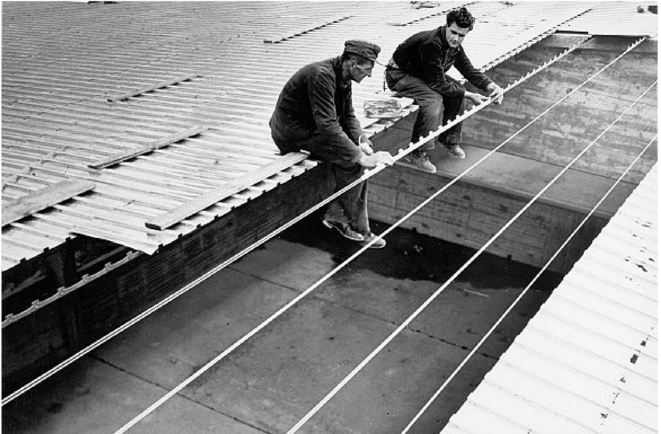
Fural auf Spannstahlträgern. Die Furalhalter sind an doppelt geführte Drähte geklemmt, womit Spannweiten von bis zu 15 m überbrückt werden können. Die Abbildung zeigt vermutlich die Fasslagerhalle der ÖBB in Inzersdorf (A), wo das Dach noch heute existiert. – Bild: Staatsarchiv Uri, Altdorf; PA «Nachlass Josef Furrer-Gisler (1910–1976) / FURAL»
