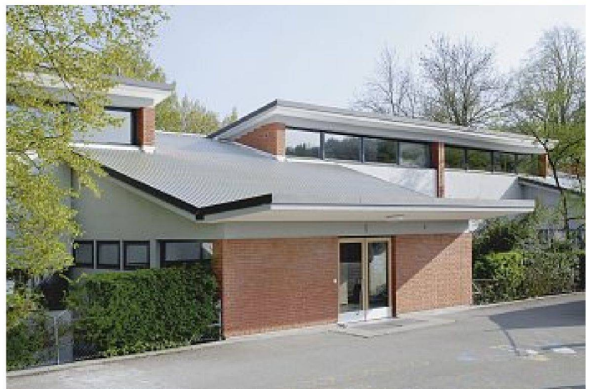
Schulanlage Untermos, Zürich-Altstetten, 1953/54, Architekt Eduard del Fabro; Umnutzung und Instandstellung, 2007–2009, Diethelm & Spillmann Architekten. – Bild: Roger Frei
