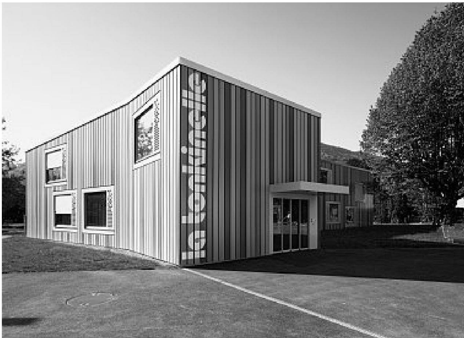
Entrée principale, façade nord
