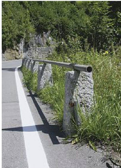
Von oben links im Uhrzeigersinn: Obere Grossgrabenbrücke mit Brüstungs- und Stützmauern – Stützmauer mit Brunnen und gemauertem Durchlass für die Entwässerung – gemauerte Hangwasserfassung mit Durchlass – Kilometerstein 25 mit Wehrsteinen Typ B – Absturzsicherung, Wehrsteine Typ A mit Verbindungsrohren – Strassenrand mit Entwässerungselementen unterhalb der Wendeplatte Heubergrank, Nähe km 27. – Bilder: Isabel Haupt
