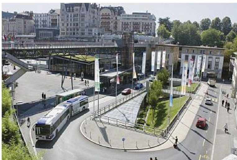
Blick von der Grand-Pont auf die Station, den Knotenpunkt Lausanne-Flon. – Bild: Transports lausannois
