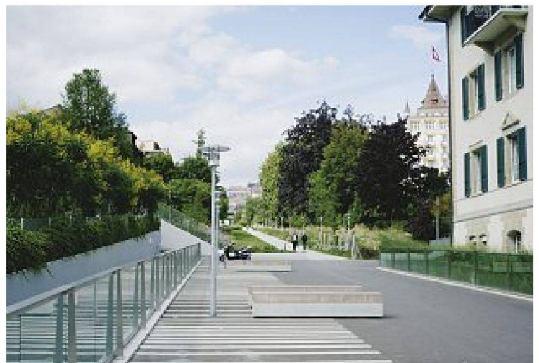
Station Jordils, Blick Richtung Norden, Richtung Stadt
