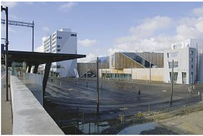
Gilberte-de-Courgenay-Platz mit Eingang an der Südseite
